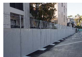
▲小学校困障改修工事
